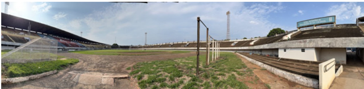
Estádio Morenã - visão interna
