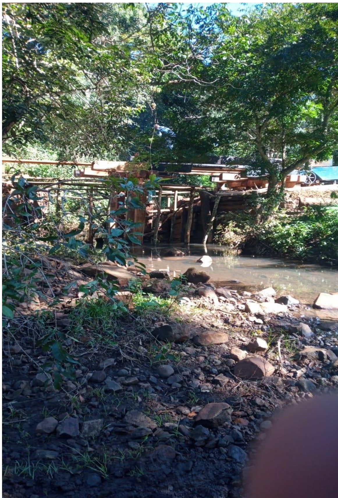
Reconstrução da Ponte
